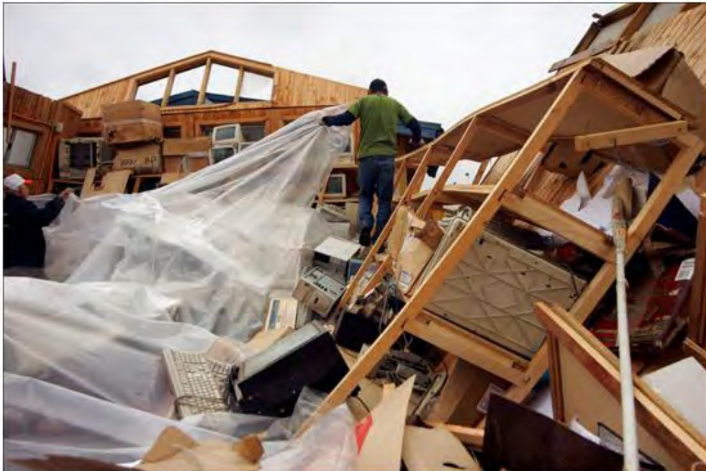
Foto 2: Producto de la intensidad del viento algunas construcciones livianas colapsaron. Foto adaptada de medios de prensa locales.
